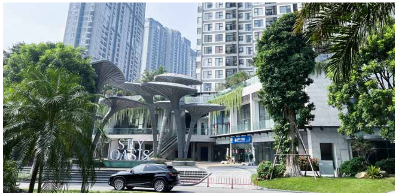
Khu đô thị vịnh đảo CT7 - Ecopark
