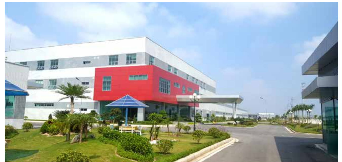
Nhà máy ACE ANTENNA - Khu công nghiệp Đồng Văn
