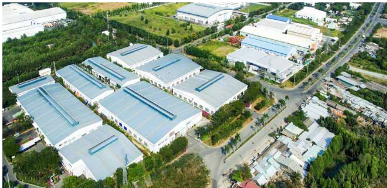
Khu công nghiệp Tiên Du, Bắc Ninh
