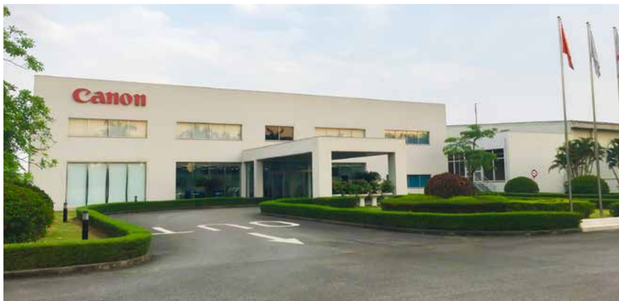
Nhà máy Canon, Quế Võ
