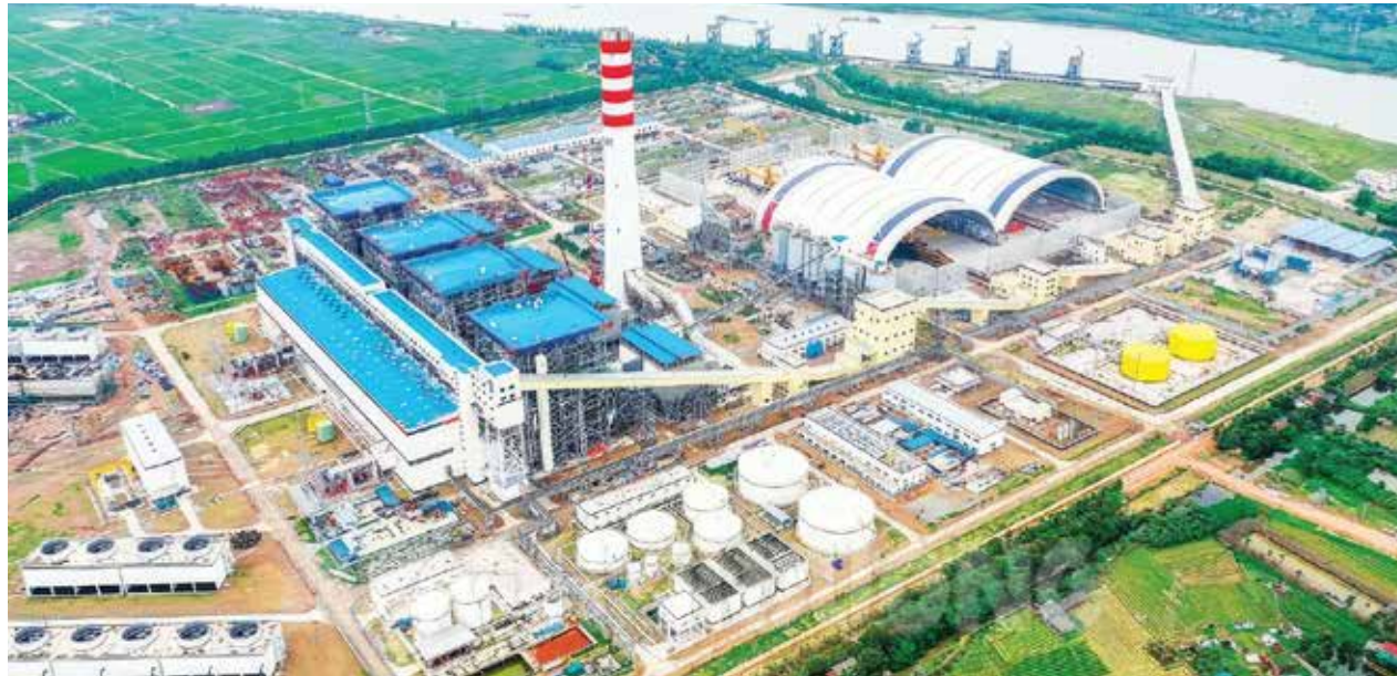
Nhà máy nhiệt điện Hải Dương - Hải Dương
